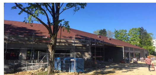
Le groupe scolaire Saint-Exupéry en construction, mai 2019
